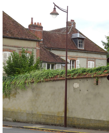
Un luminaire de style revisité, à la lisière entre le vieux Sézanne et les quartiers neufs
