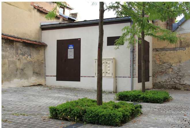
Le poste EDF de l'Ancien Collège
